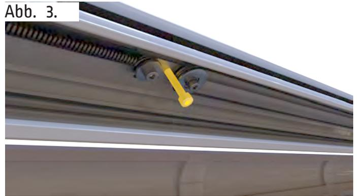
Sichern Sie die Vorspannung der beiden Federn durch je eine Arretierungsschraube.
