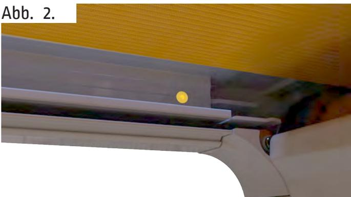
Fahren Sie die Ancona ca. 30cm aus und lösen die Innensechskantschraube an der Innenseite beider Führungsschienen.
