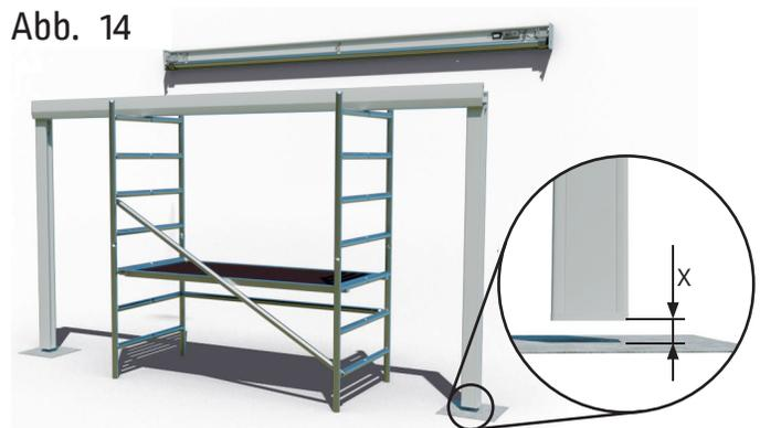
Dafür werden Gerüste oder Böcke benötigt, die die Rinne in der Endposition halten. Die Pfosten müssen dann etwas über den Fundamenten schweben.
